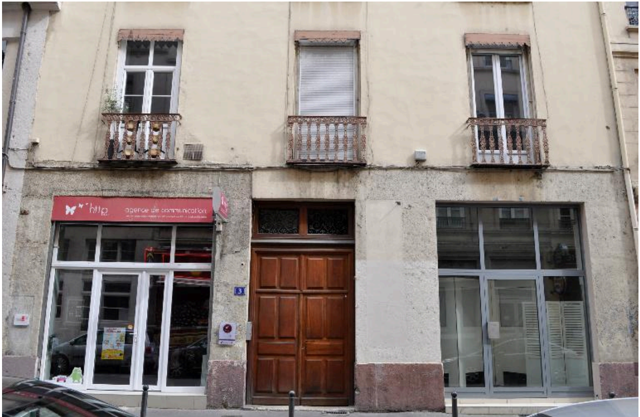
Vue rapprochée du rez-de-chaussée et du premier étage
