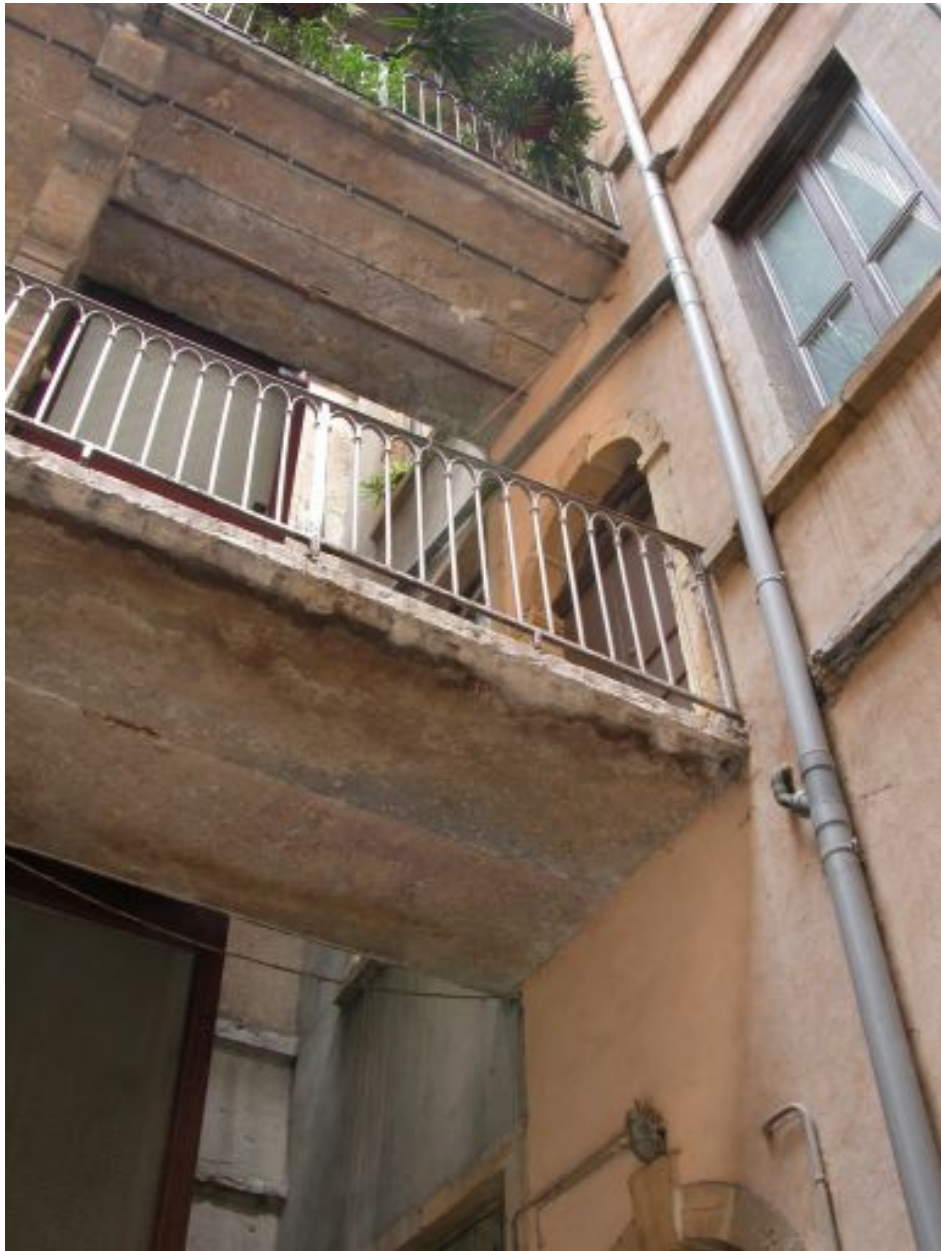
Cour, coursières des 2e et 3e étages
