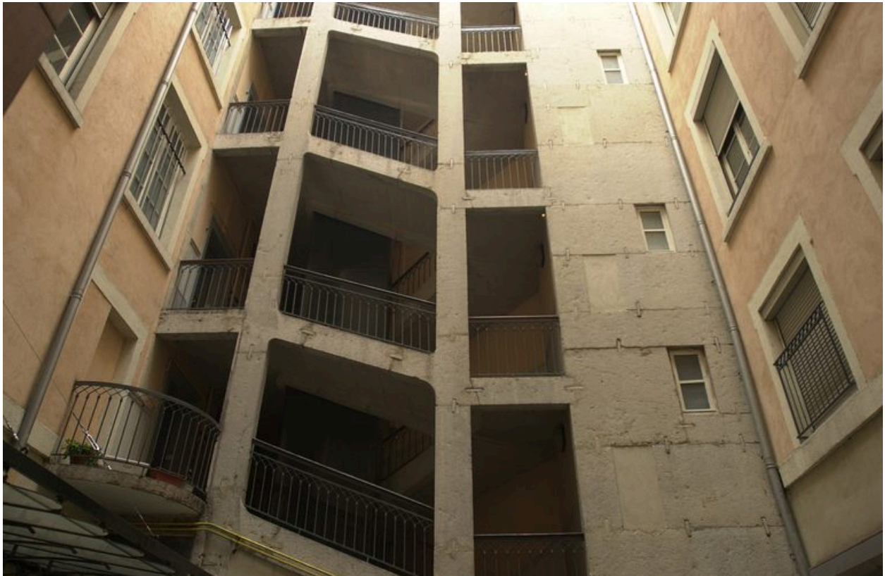
La cage d'escalier ouest : partie supérieure
