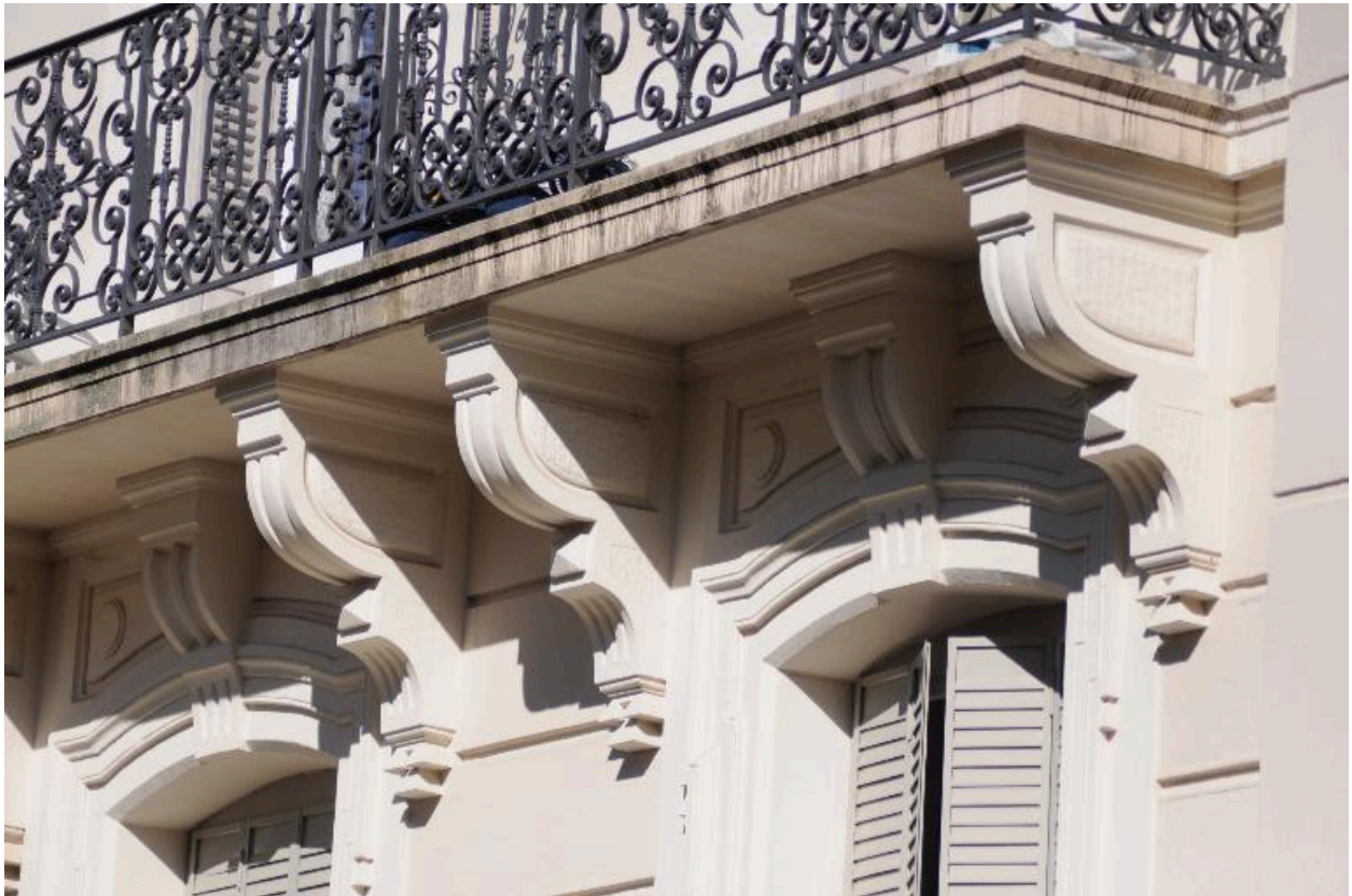
Dessus-de-fenêtres du rez-de-chaussée surélevé et consoles des balcons du 1er étage
