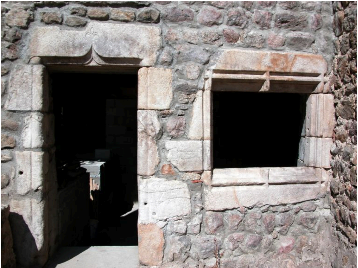
Détail de la façade sud du logis 4 (état en 2011).
