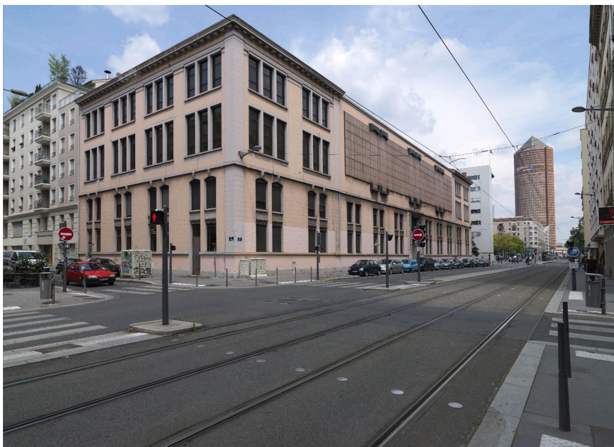
Façade principale des Archives départementales du Rhône
