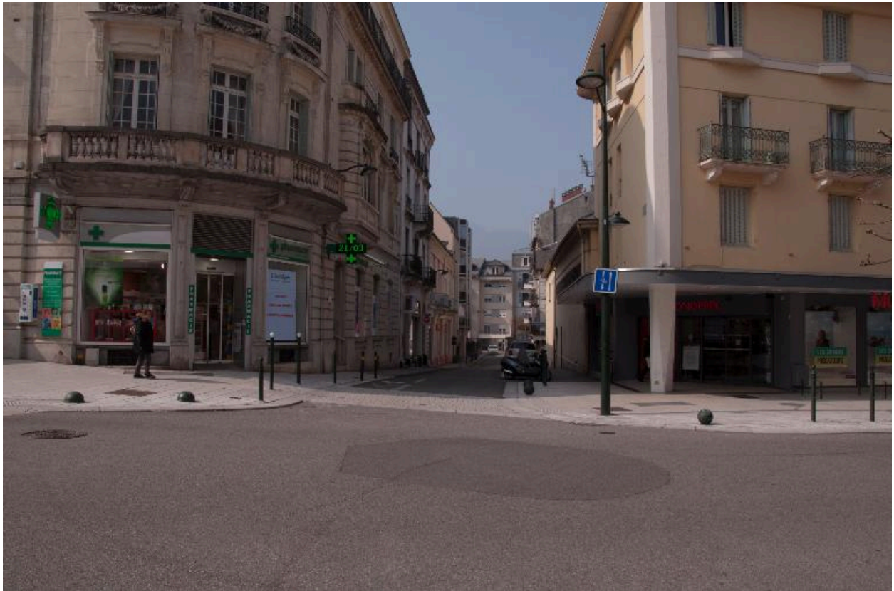
Vue vers l'ouest depuis la rue de Genève
