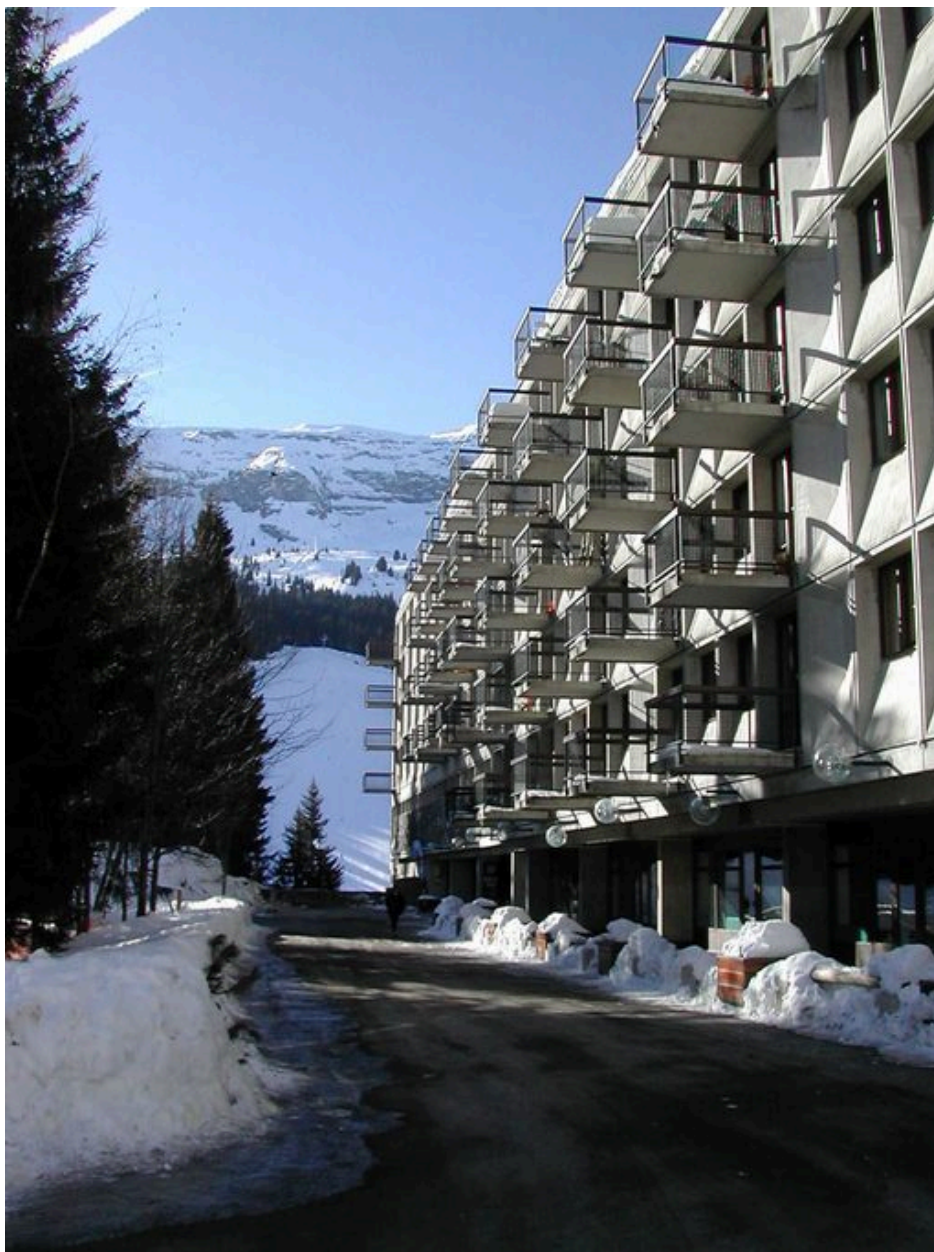
Elévation principale. Vue depuis le nord
