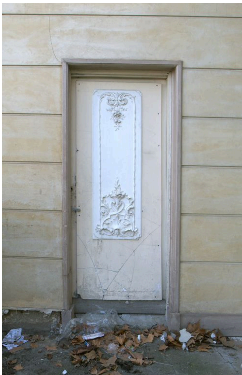
Elevation latérale du 148 route de Genas, détail des décors sculptés de la porte
