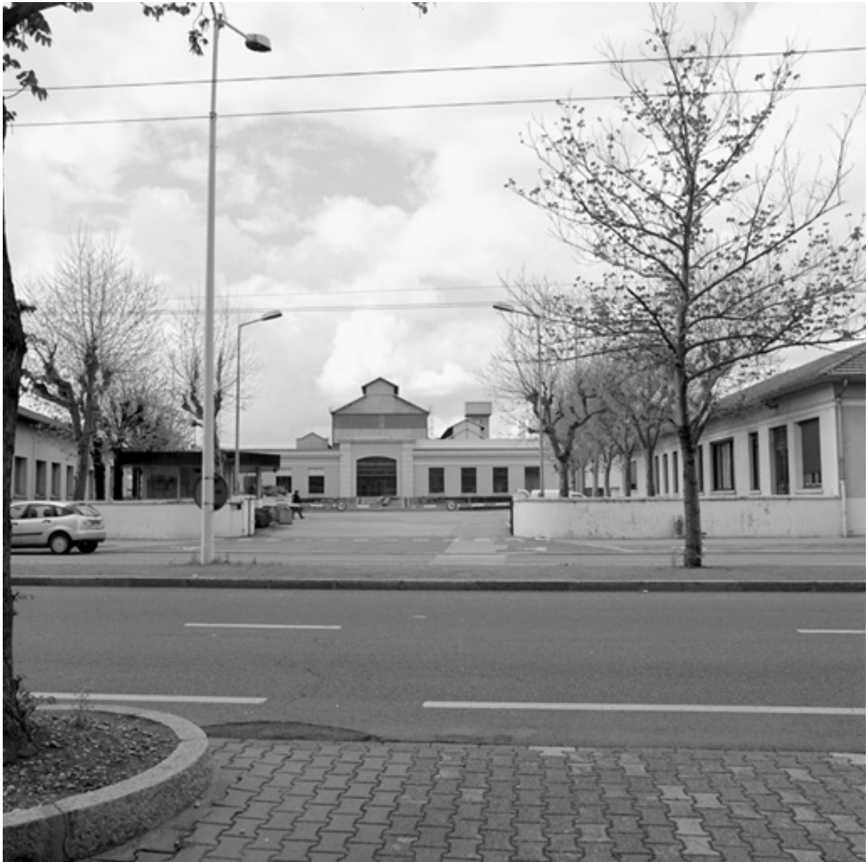
Vue d'ensemble nord
