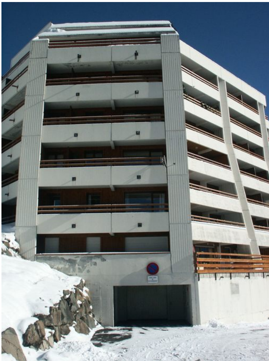
Vue depuis l'ouest
