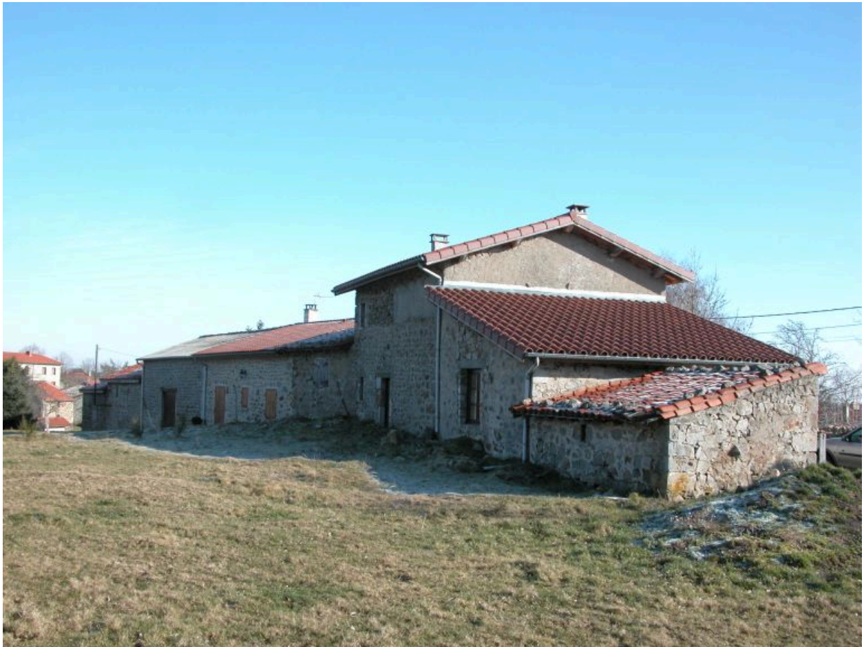
Vue d'ensemble des façades arrières des bâtiments.
