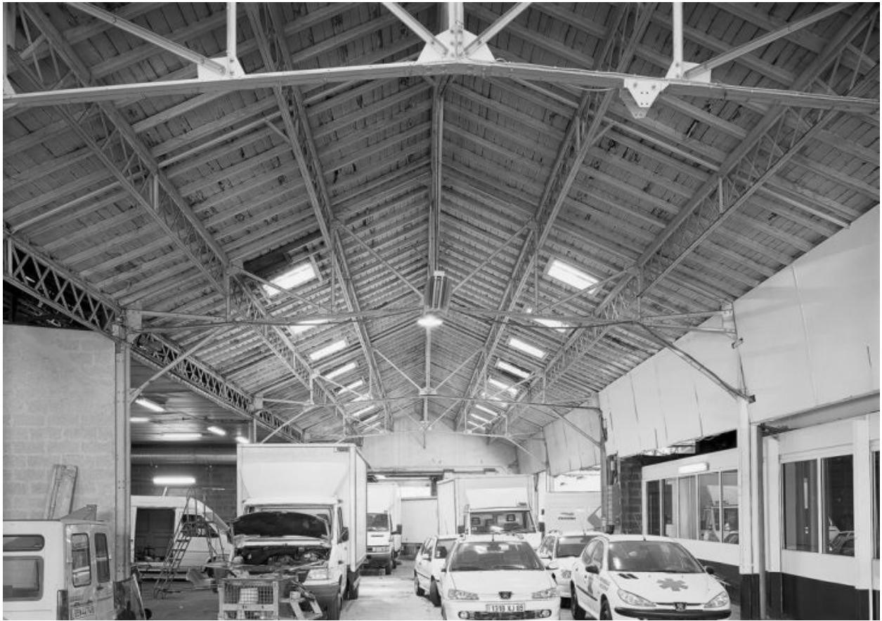
Vue du hangar central depuis l'ouest
