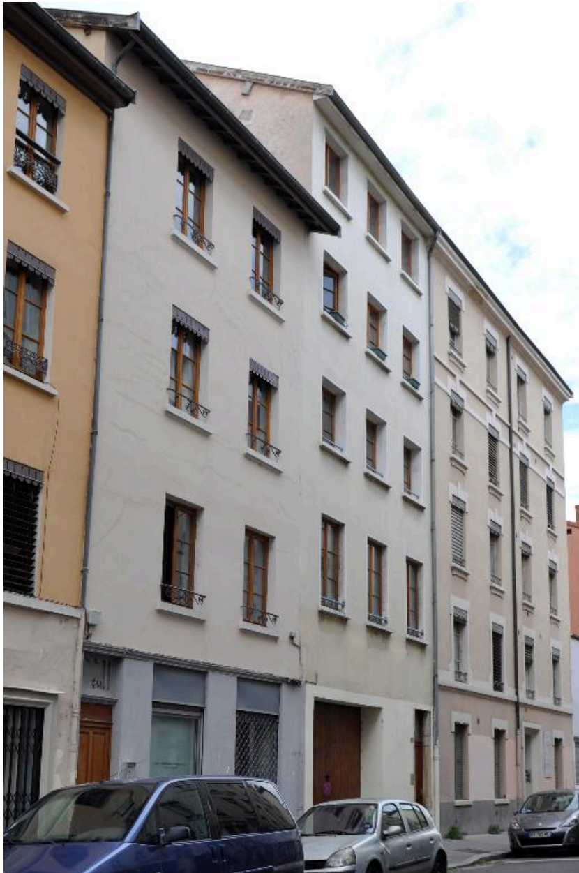
Vue d'ensemble, élévation sur rue
