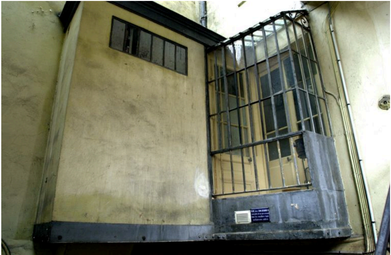
Vue des structures en surplomb contre l'élévation postérieure du corps de bâtiment sur rue
