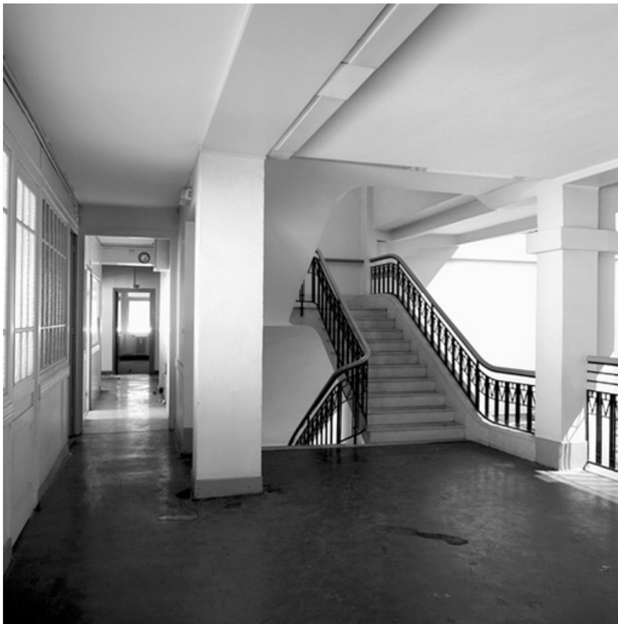
Vue de l'escalier
