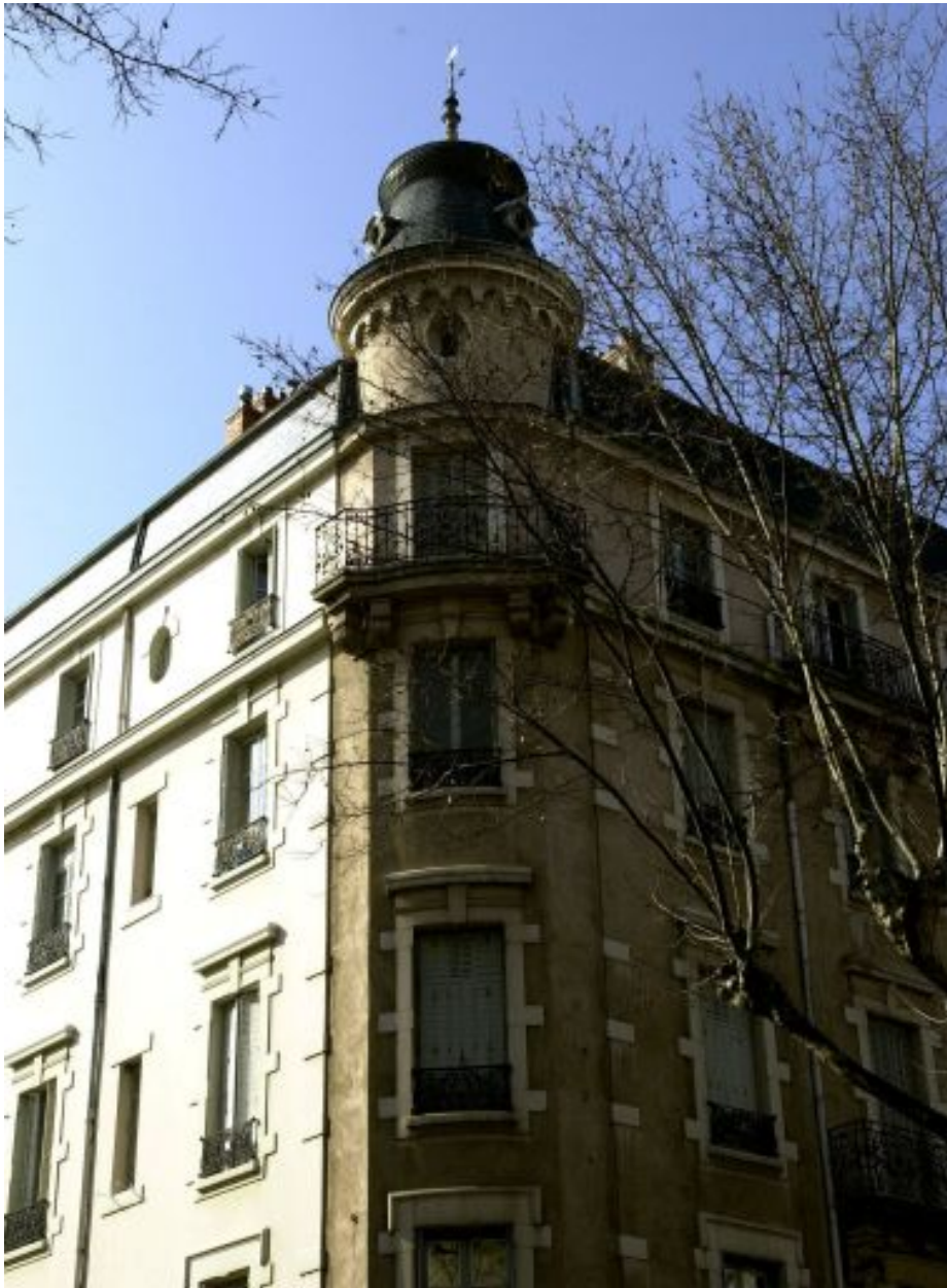
Détail du lanternon à l'angle du cours Suchet et de la rue Denuzière
