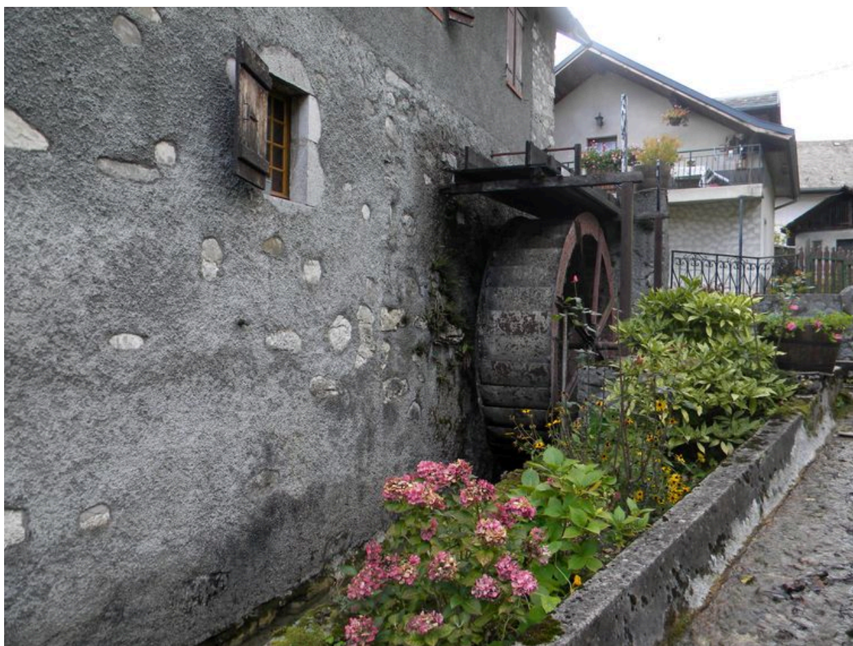
Vue de la roue sur la façade arrière.
