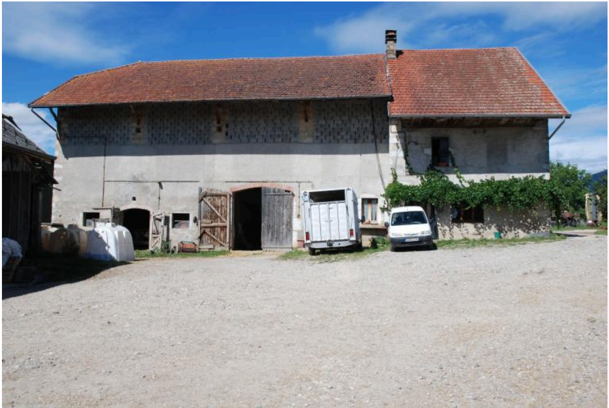
Vue d'ensemble du bâtiment principal.
