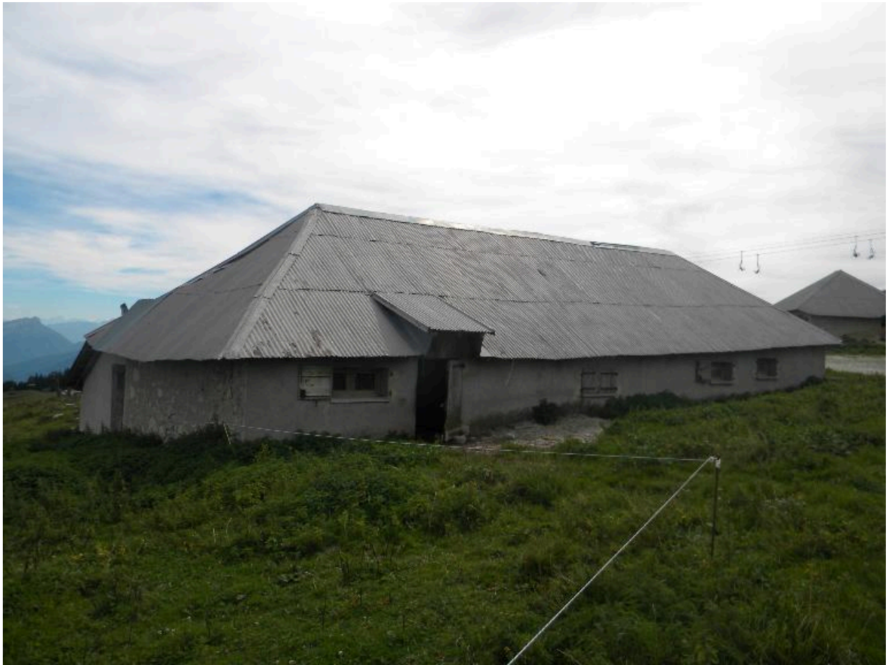
Vue de la façade nord de l'ancienne porcherie.
