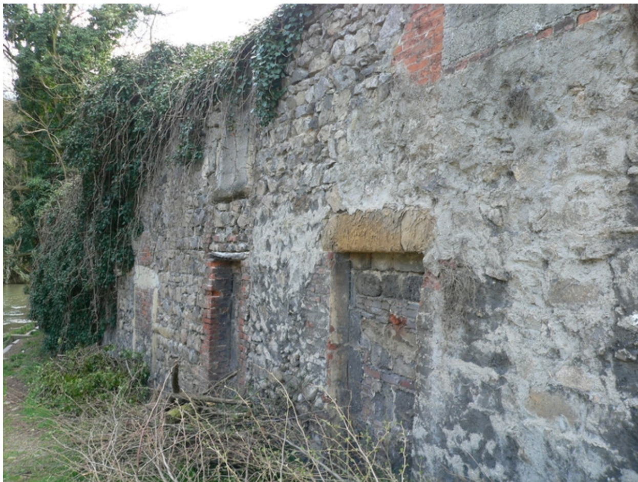
Les anciens murs de l'usine De Piellat
