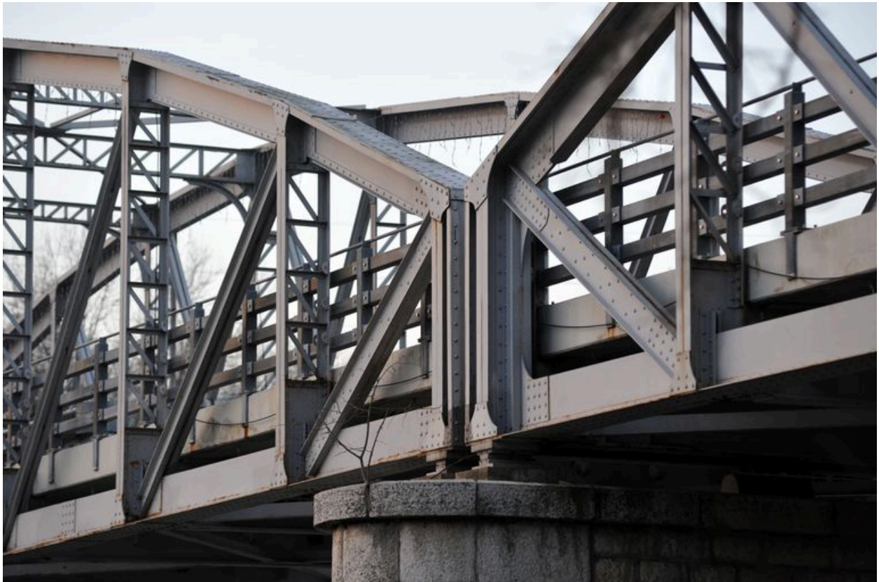
Pile gauche, face aval, vue de détail : jonction avec les arches (depuis la rive gauche)
