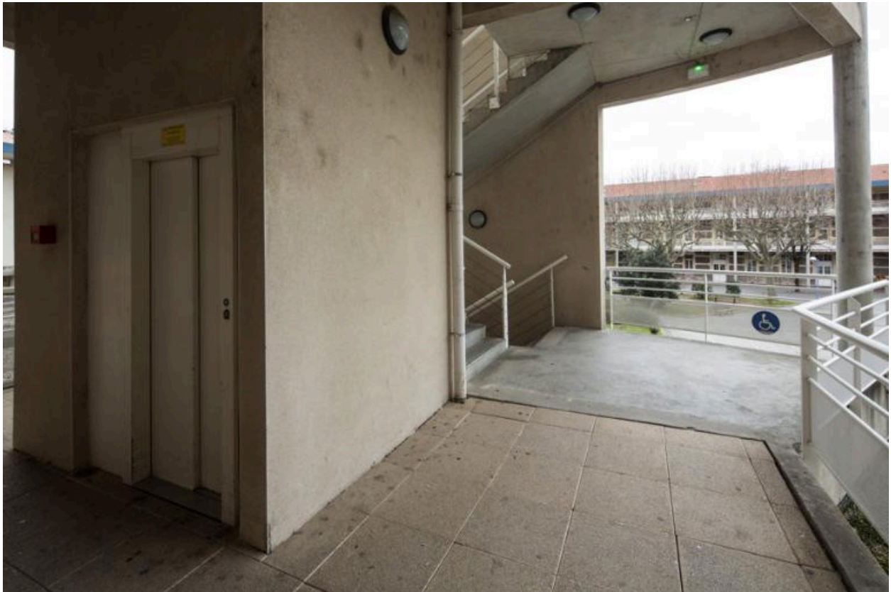
Bâtiment nord : avant-corps central, ascenseur et escalier
