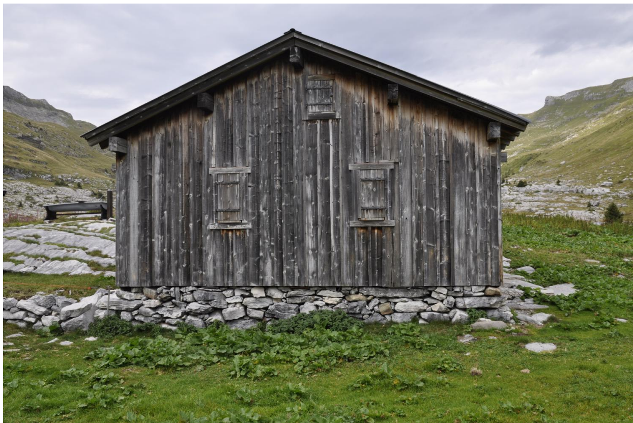
Vue du mur pignon nord
