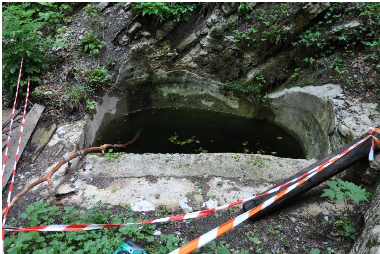
Vue d'une de deux fosses inondée
