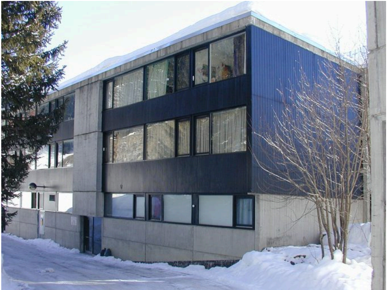
Façade nord, vue depuis l'ouest
