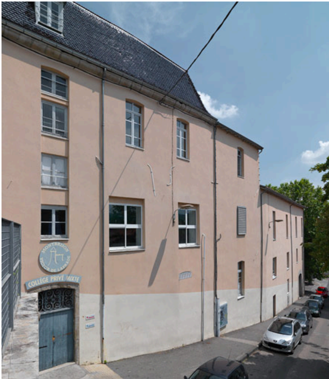
Bâtiments A et F, rue du Collège
