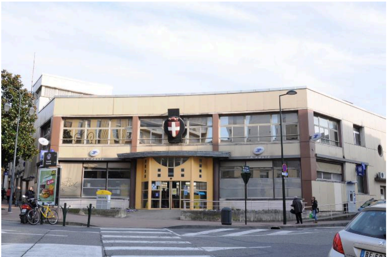
Vue générale prise du nord-ouest
