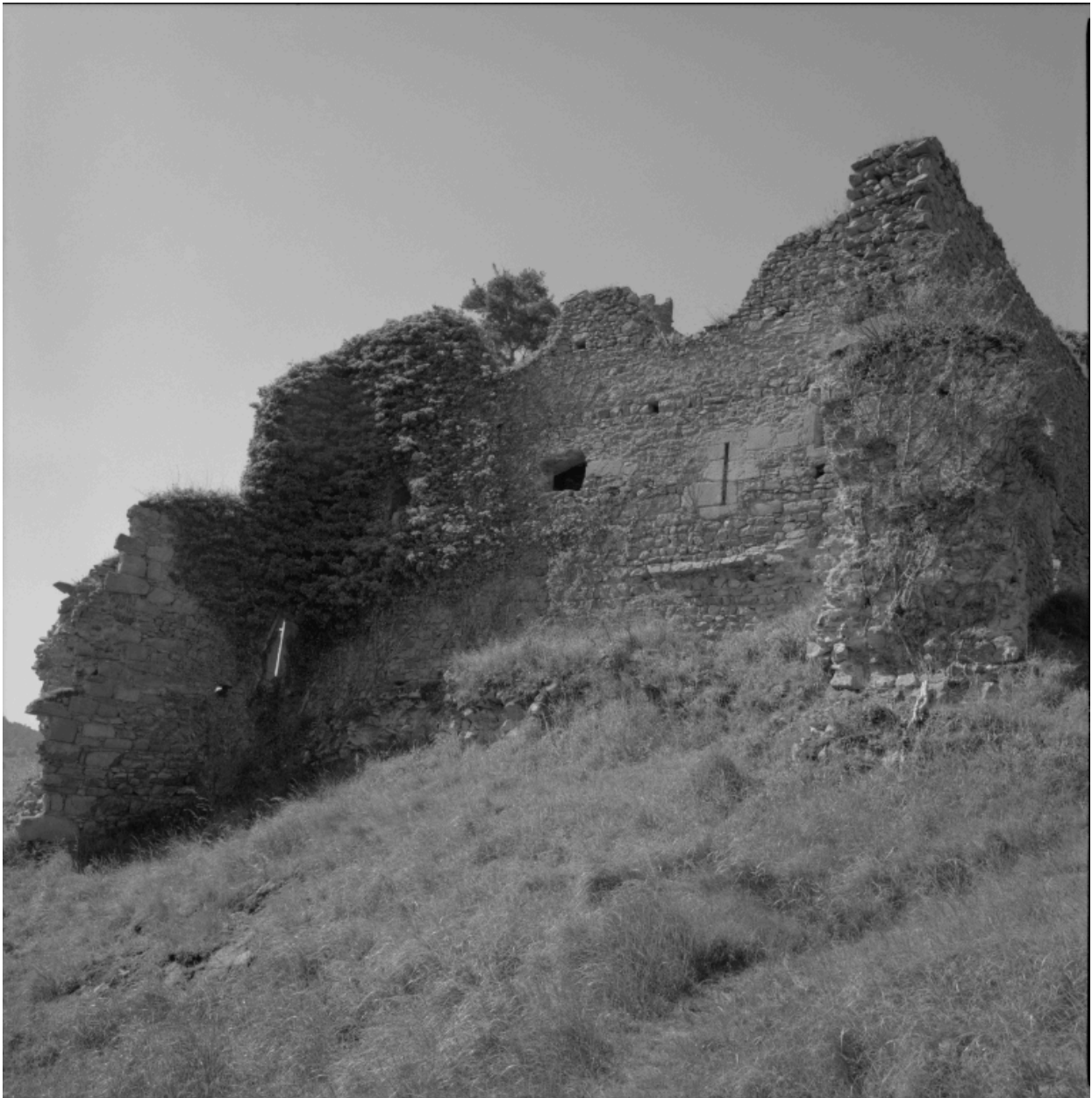
Premier baile, partie nord-est : vue des murs de la deuxième enceinte arrachés, d'une archère à étrier et d'une archère cruciforme, du nord-est.
