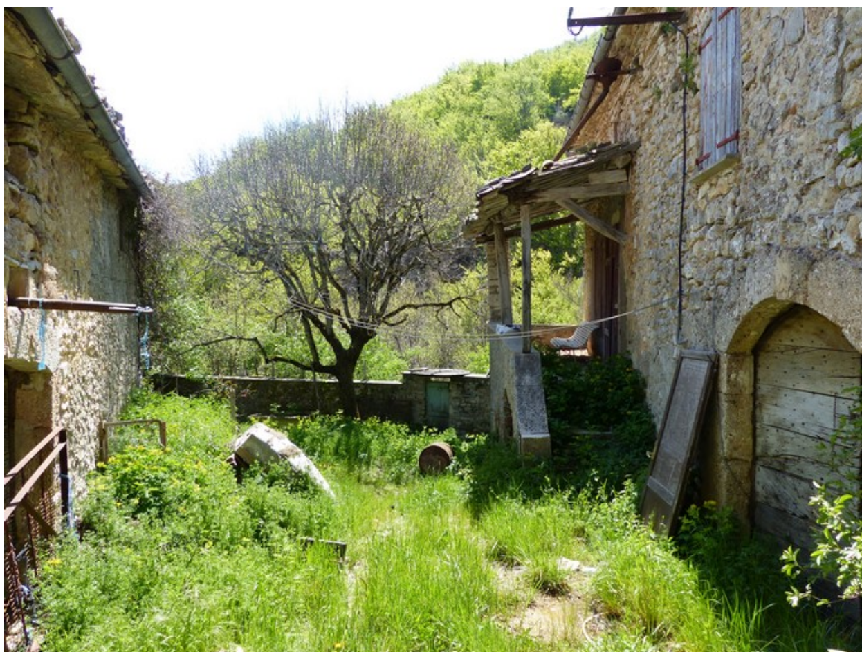
Cour, vue d'ensemble prise du nord.
