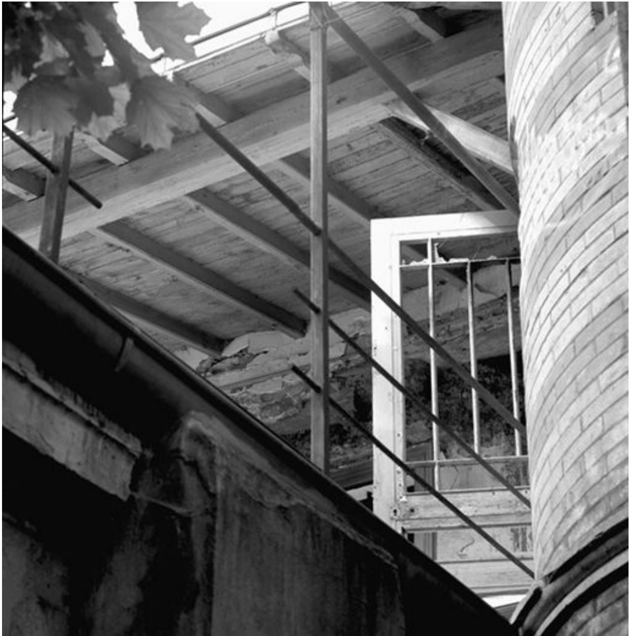
Façade postérieure, détail de la galerie du premier étage
