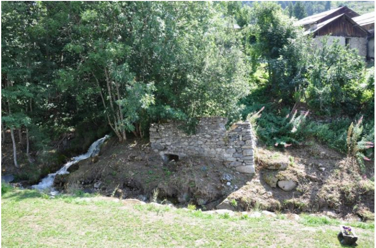
Vue du moulin du pont (moulin aval).
