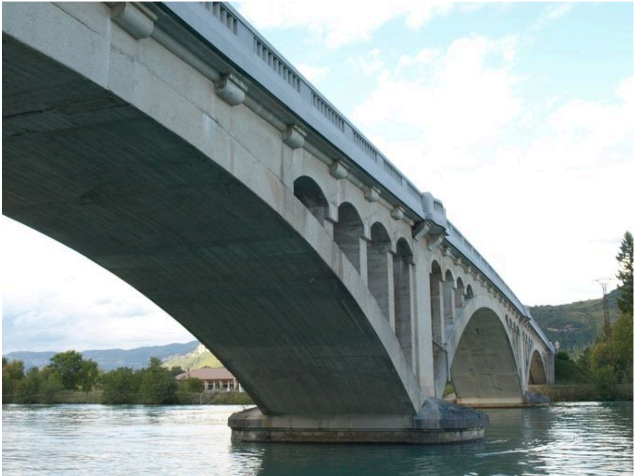
Vue de la voûte (depuis la rive gauche)
