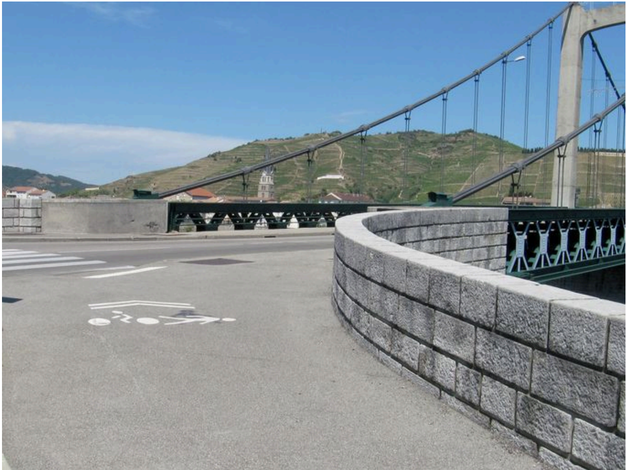
Massif d'ancrage et aile de pont, face aval (depuis la rive droite)
