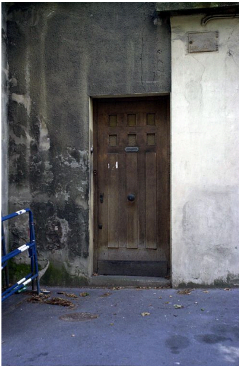
Logis, façade sur rue, détail de la porte d'entrée gauche
