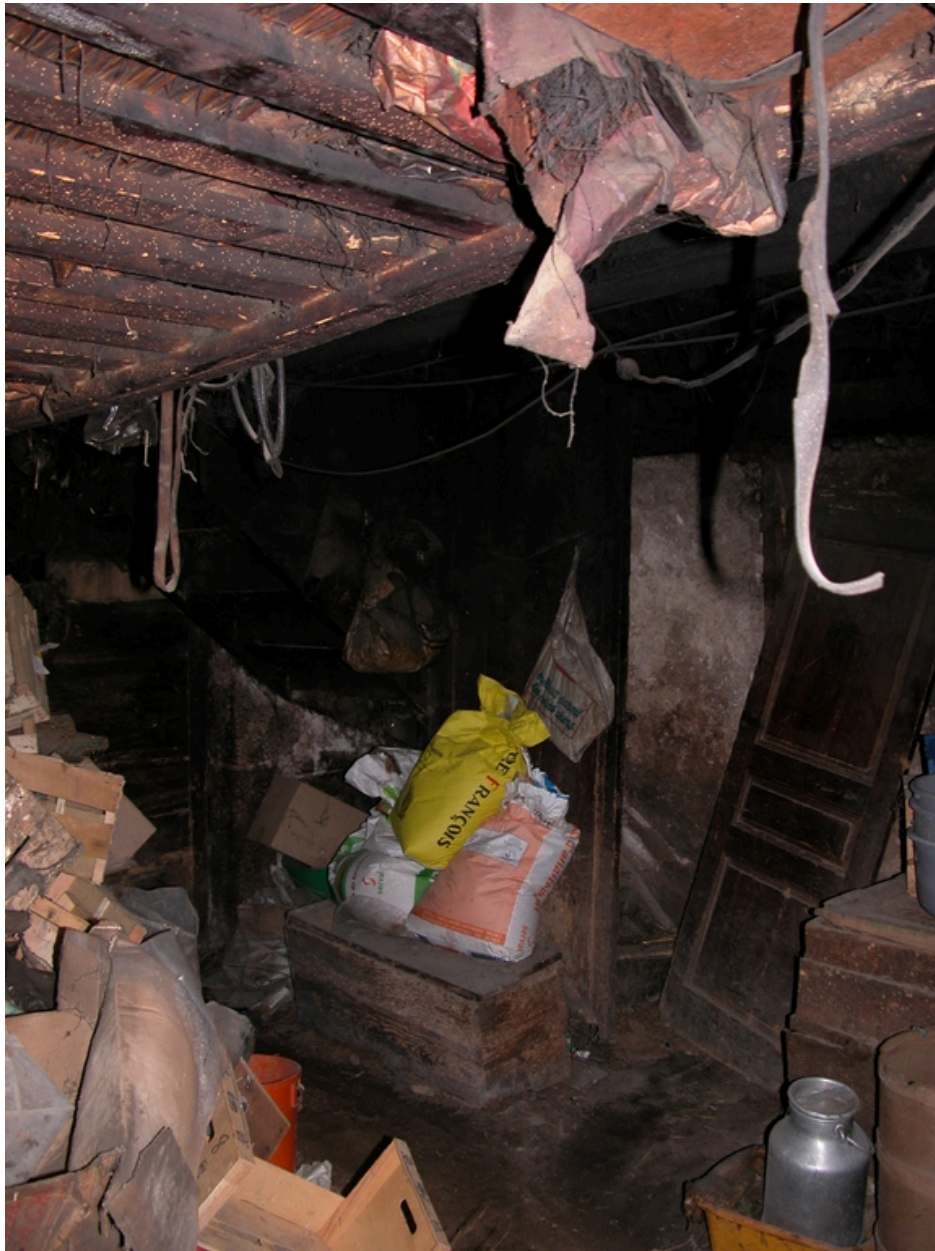
Vue intérieure de la cuisine : départ de l'escalier.
