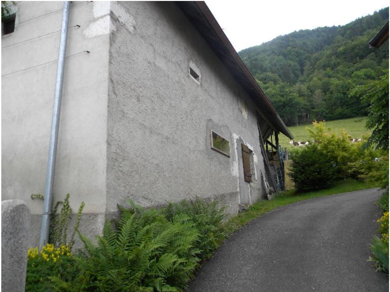
Vue de la façade arrière.
