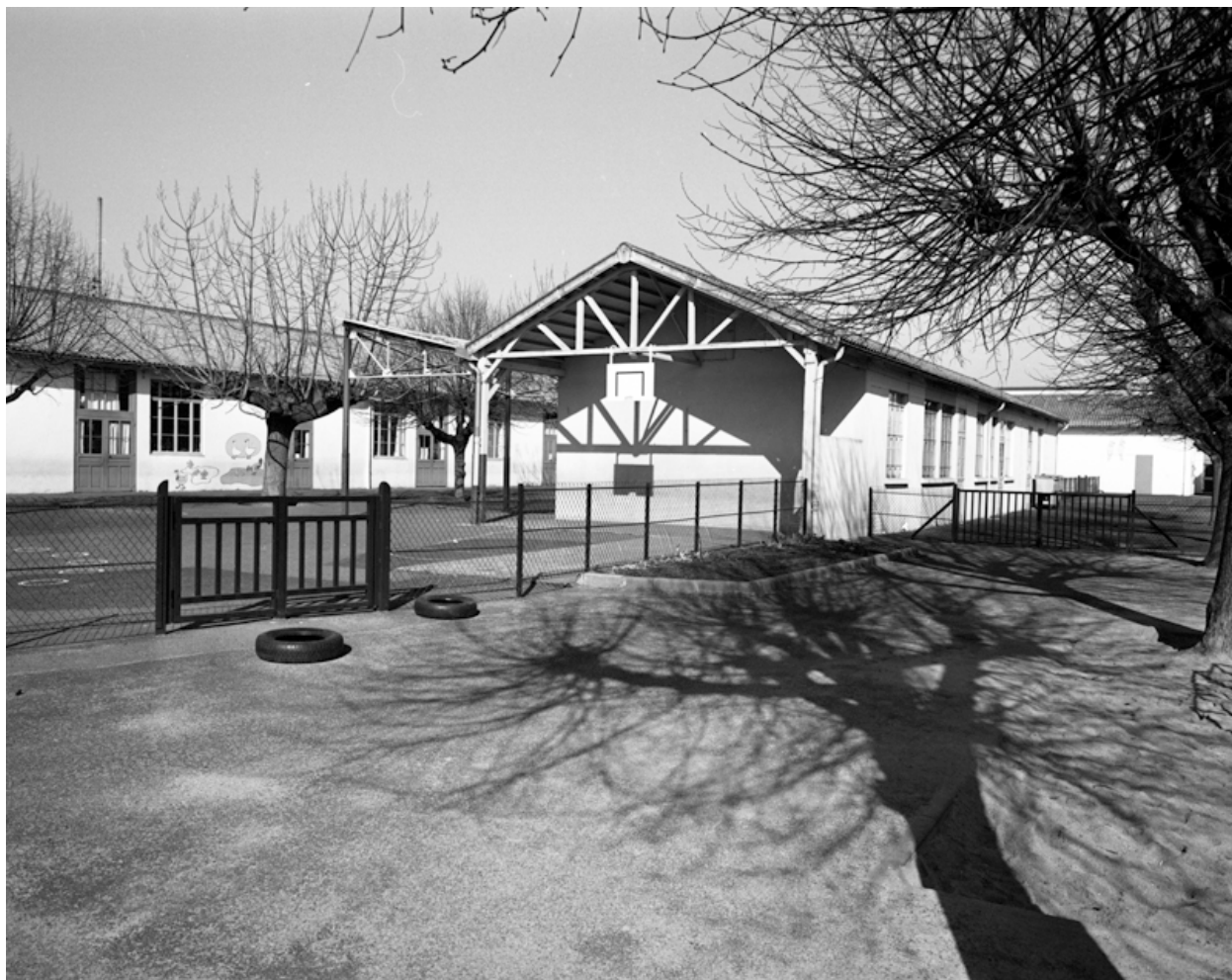
Cour de l'école Diderot, depuis le sud.
