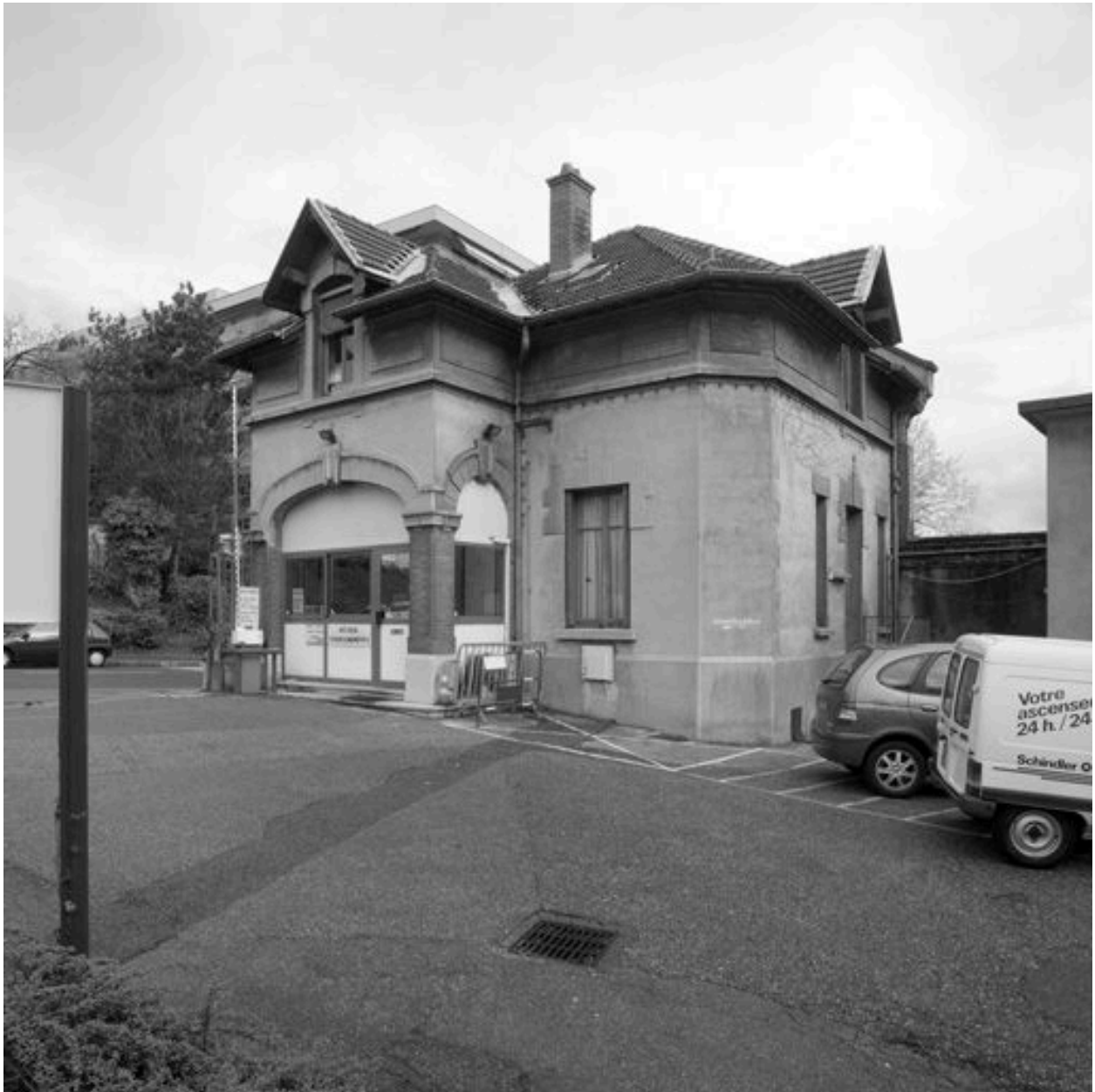
Bâtiment 14, façade sud
