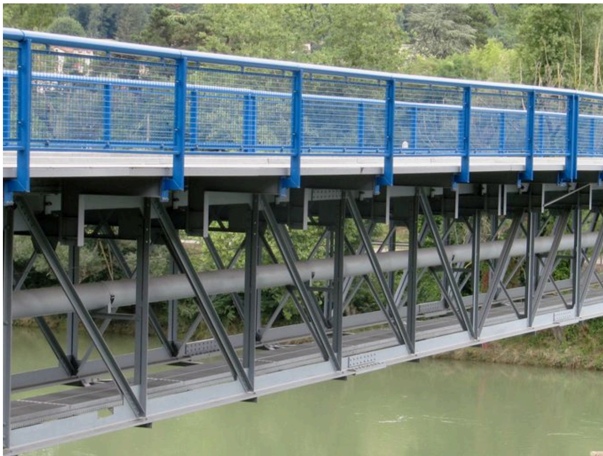
Vue partielle du tablier, face amont (depuis la rive gauche)
