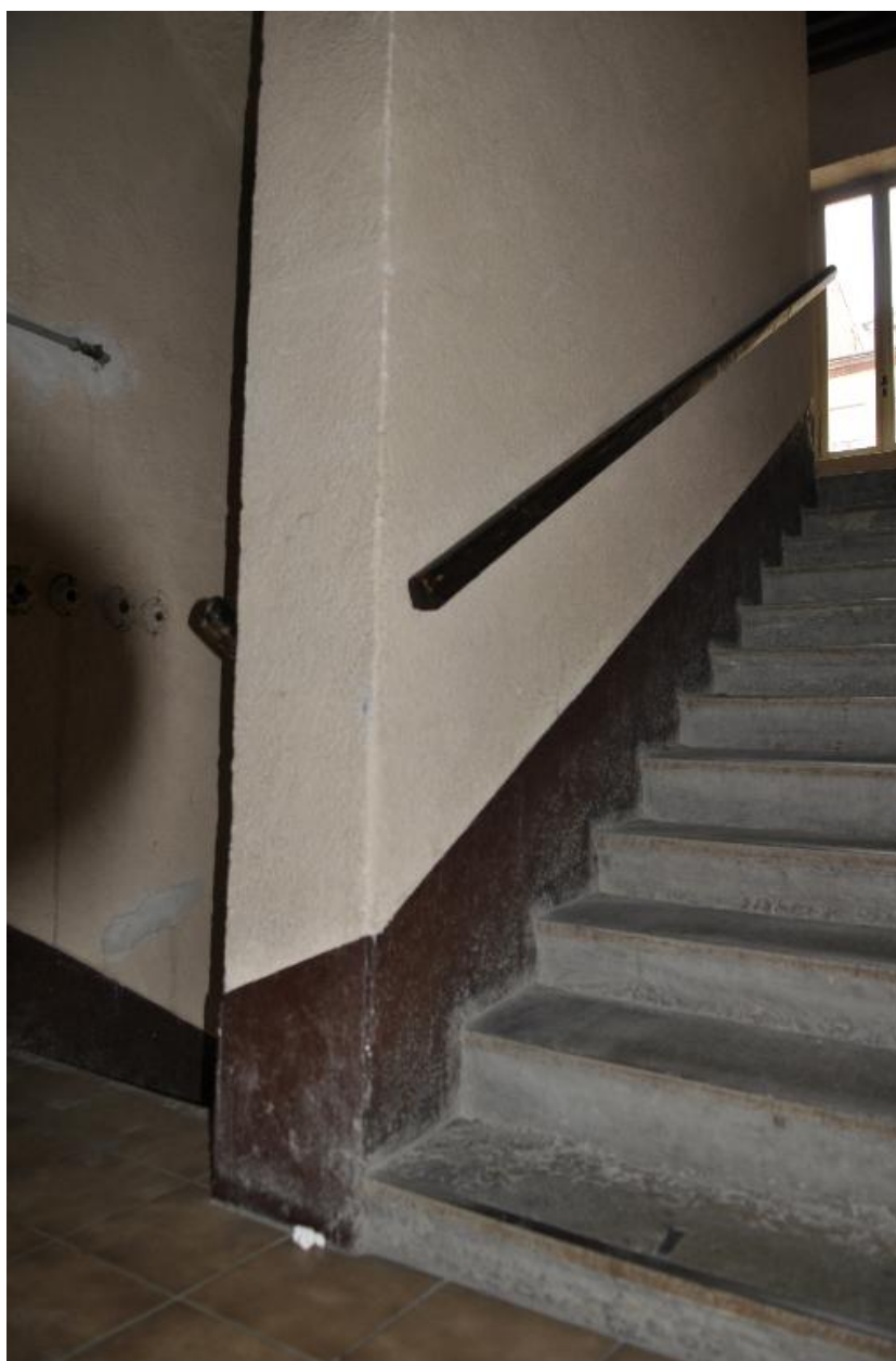
Mur noyau plein de l'escalier du n°15 rue Dumenge
