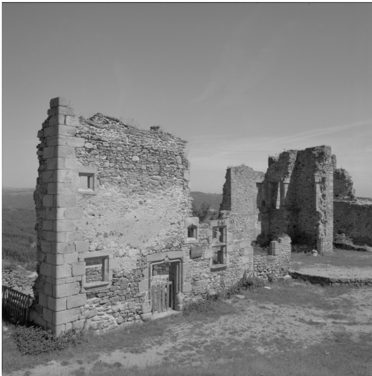
Premier baile, première enceinte, partie nord : vue du logis dit logis du Capitaine, du sud.
