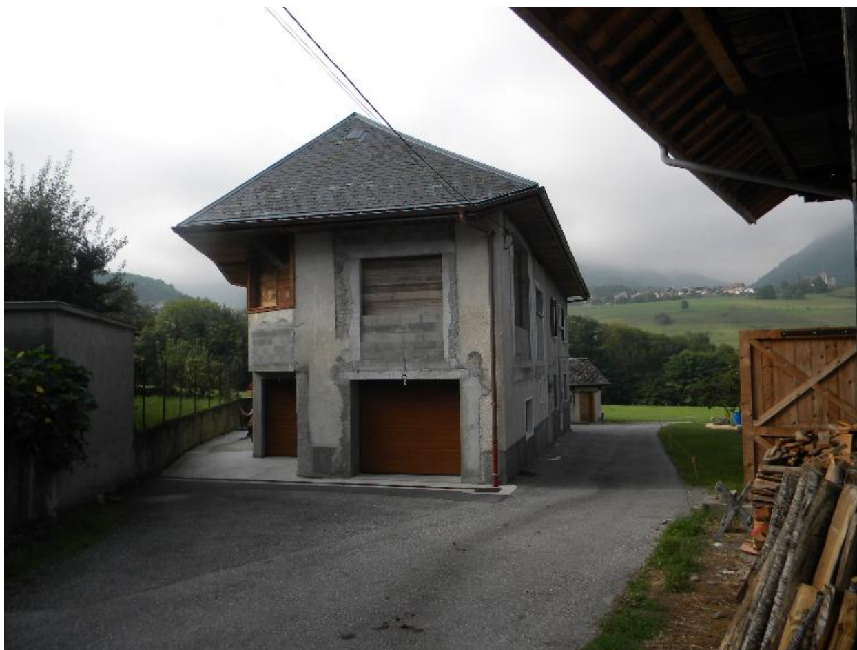
Vue du pignon est d'une ancienne ferme transformée (2008 E8 1161).
