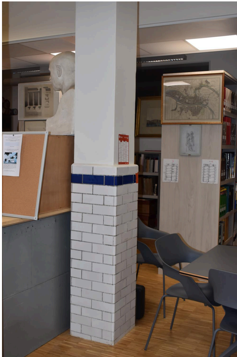
Elément de carrelage des anciens bains-douches
