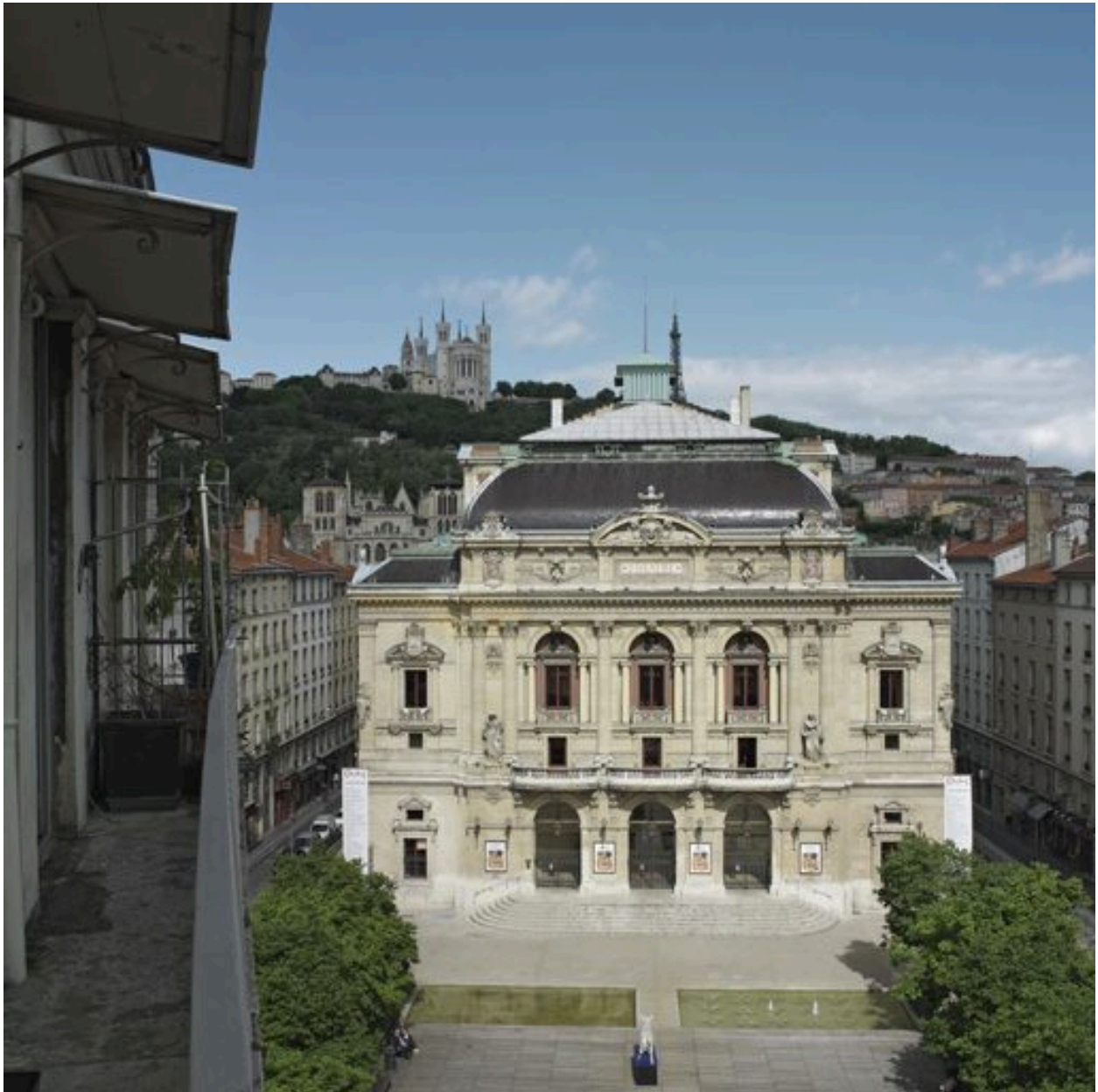
Vue de situation depuis le balcon du dernier étage de l'immeuble sis 5 place des Célestins
