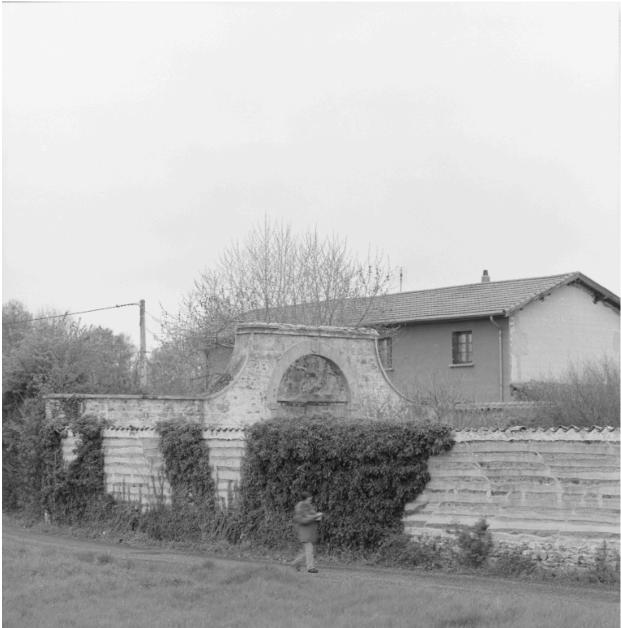
Vue du portail nord du parc qui communiquait avant 1843 avec le village d'Arthun, depuis le chemin rural n°10, du nord-ouest.
