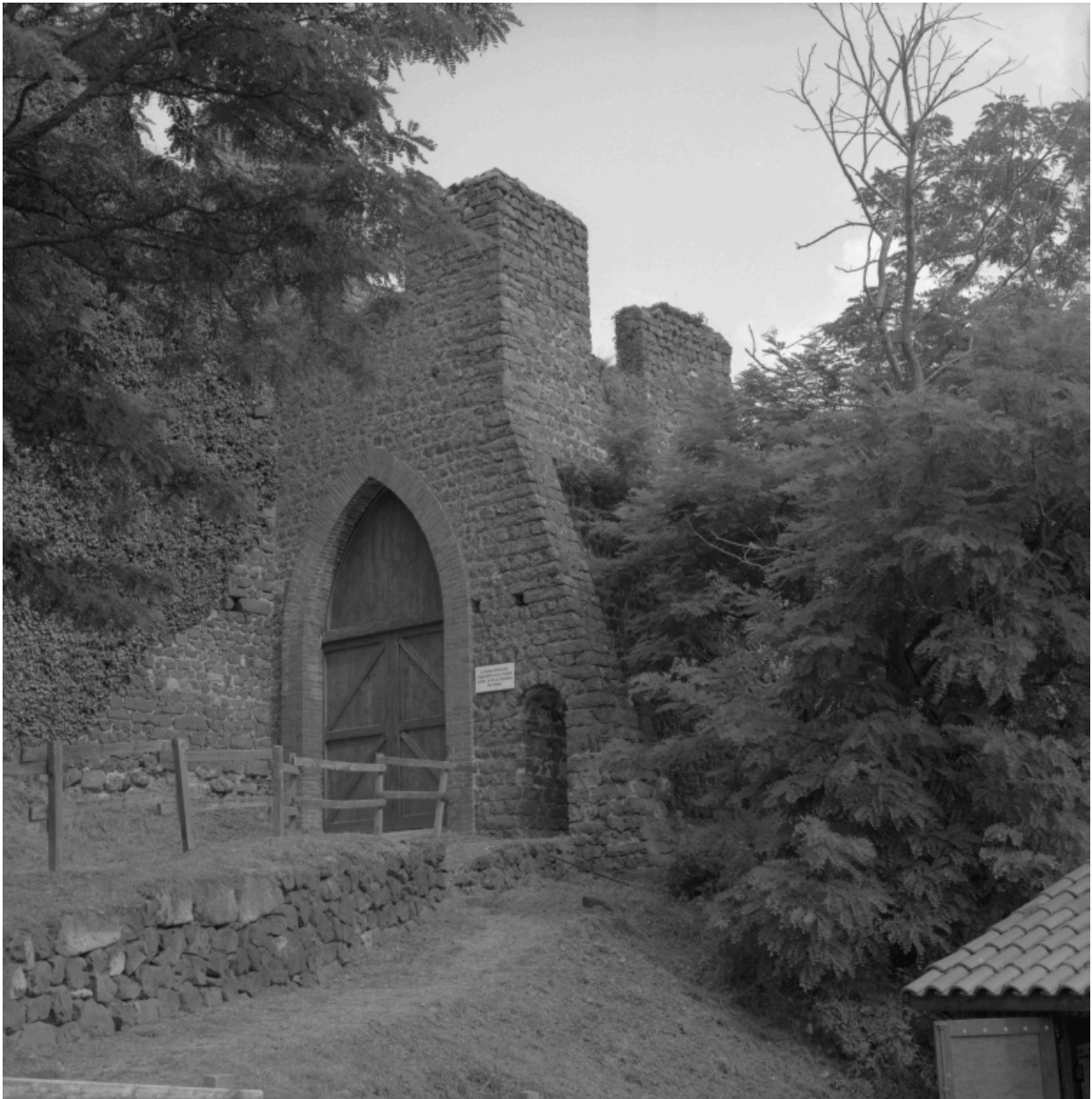
Vue extérieure du portail d'entrée, depuis le nord-ouest.
