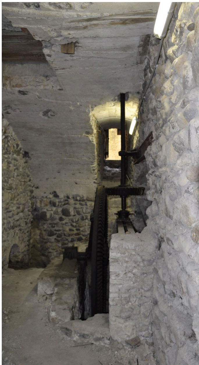
Ancien système hydraulique (vue d'intérieur)
