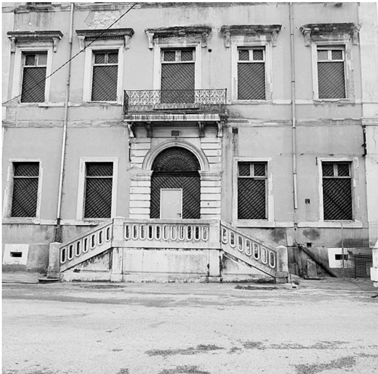
Entrée principal du pavillon sud (façade ouest)
