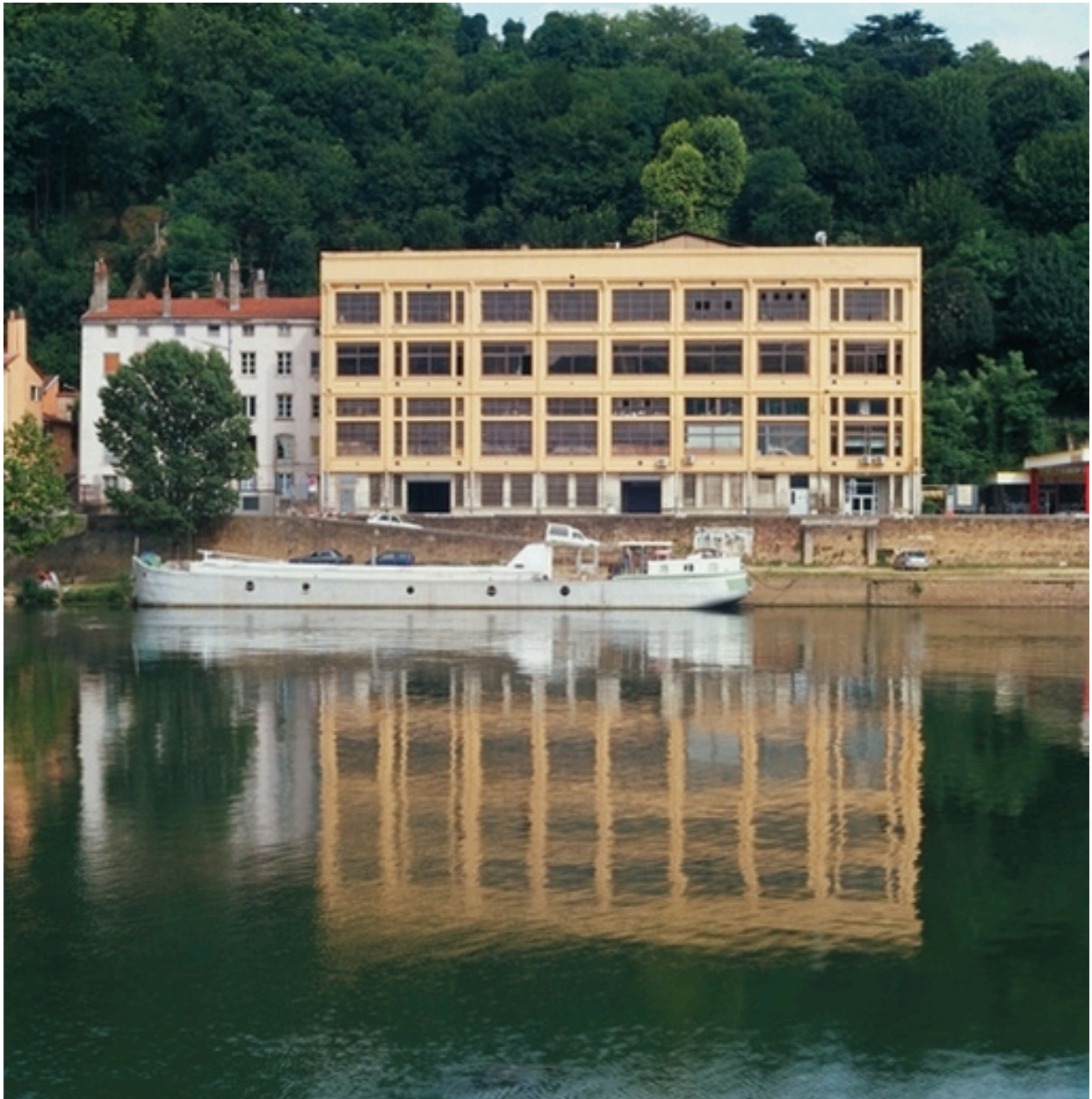
Vue générale ouest
